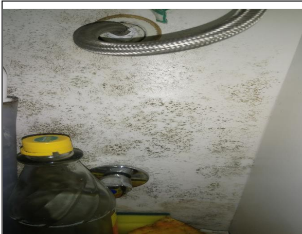
Foto N°55: 26 de enero de 2021 Humedad en muro de cocina de la vivienda ubicada en calle Monteáguila 2 Oriente N° 1081.
